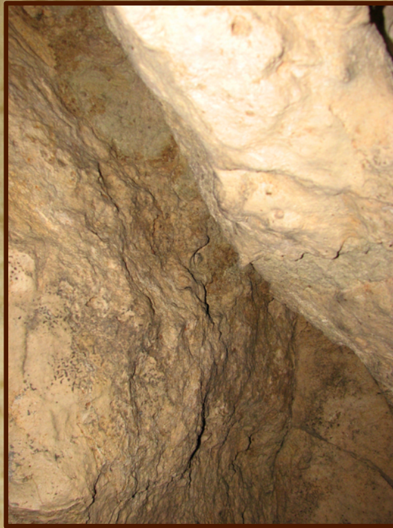
Kitöltött repedés a Mamutfogas teremben
