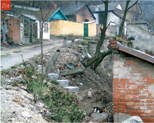
2. a, b képek: Az enyhe lejtőmozgások környezetében jellemzőek az épületek falain keletkezett repedezések
